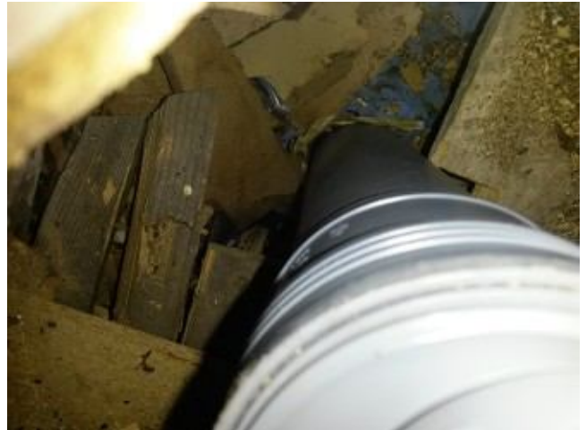
Jos allasviemäri vuotaa, menee vuoto lattiarakenteisiin.
