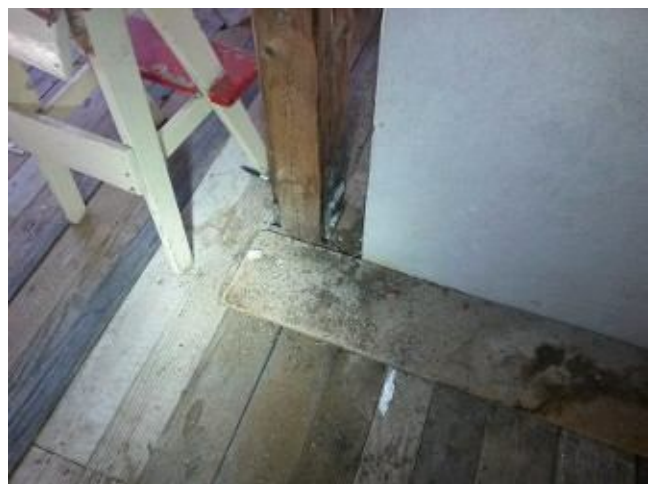
Muurahaispesä katon rajassa ja myös välilaipion kohdalla
